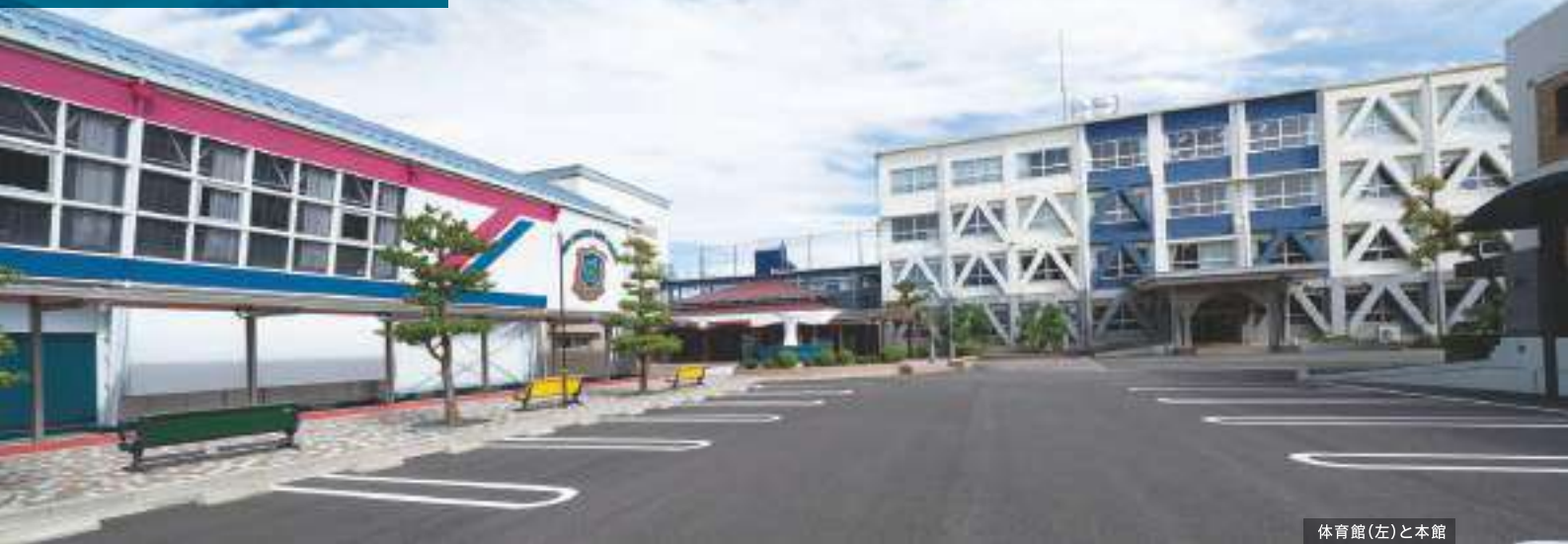
体育館(左)と本館
