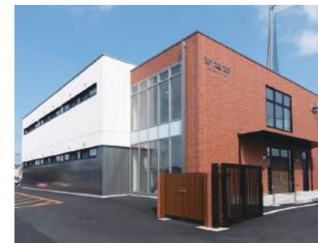
New 漸進館・玄関ホール
